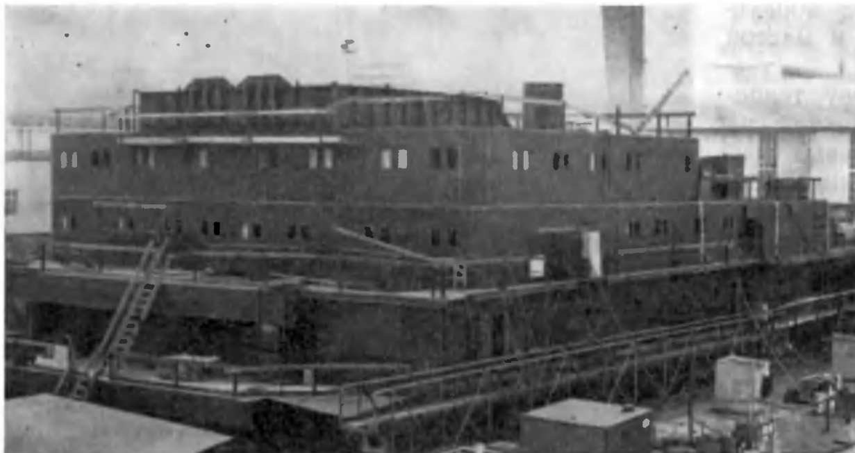
Рис. 6. Блок надстройки на преддоковой площадке.
